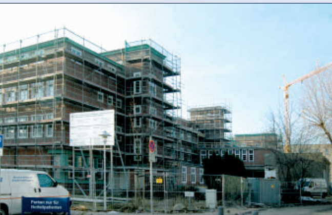
Bauarbeiten am Haus 10
