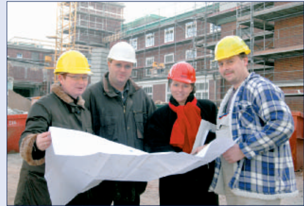
Absprache vor Ort zwischen Silvia Felde, Projektsteuerin der Uni-Klinik, Marko Wenzel, Bauleiter des Architekten Dr. Ribbert Saalman, Katrin Jurke, Bauleiterin der Uni-Klinik, und Dirk Schmidt, Fliesenleger der Firma Fliesenrabe (v.l.) (Fotos: Elke Lindner)
