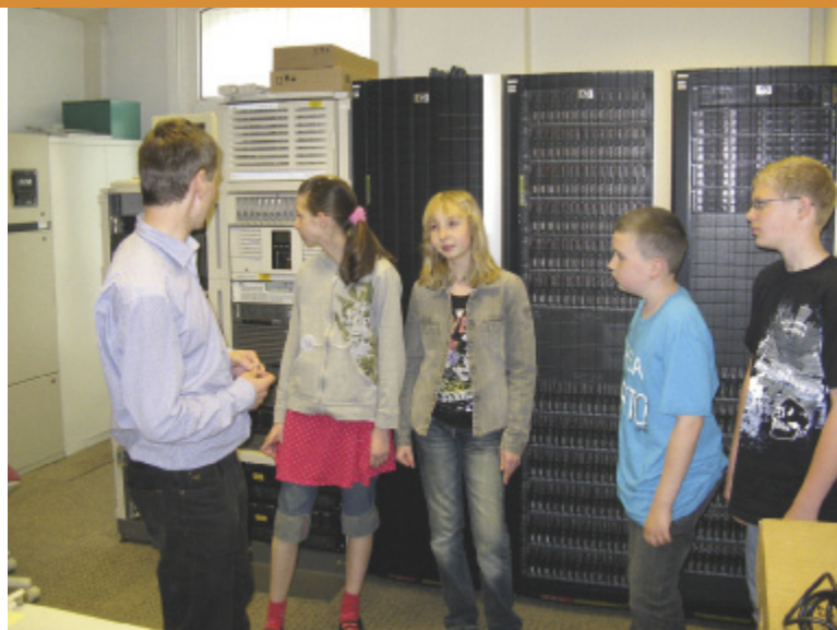
Dr. Harald Hofmann zeigt den Siebtklässlern zentrale Datenspeicher und Server für klinikumsweite Anwendungen (Foto: Stefan Feige)
